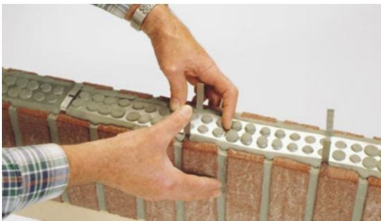
Nach Fertigstellung der Grenadierschicht wird das MOSO® Lochband zwischen die Bügel gelegt. Danach werden die Lochbandbügel einfach zugebogen, fertig.
