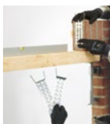
▲ ... während des Mauerns auf den Stein aufhängen...
