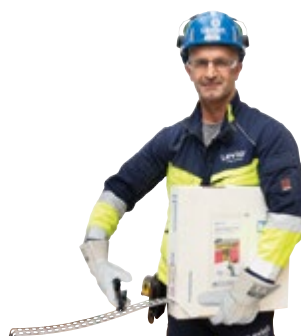
▲ ... und mit einer Blechschere abschneiden
